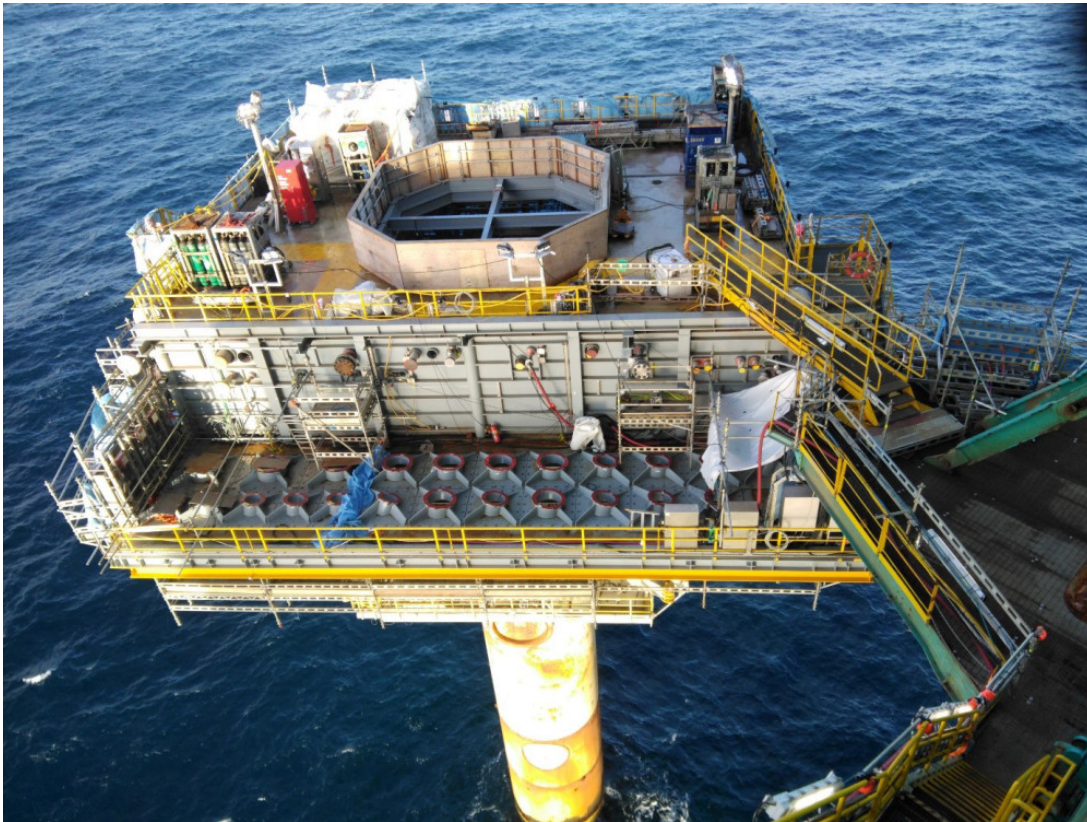
Caisson med Wellhead modulen på plass.
