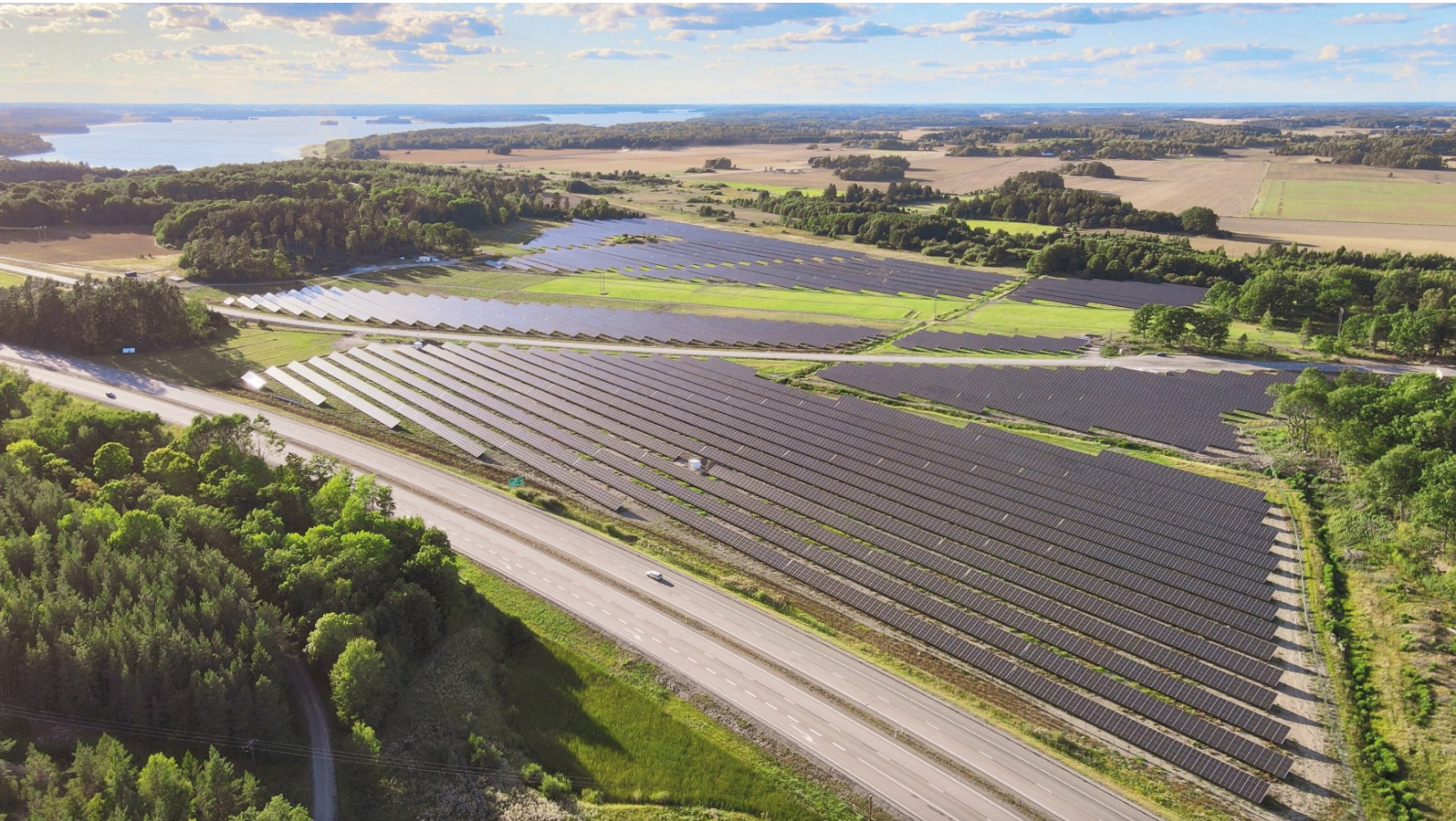
HSB Södermanlands Solcellspark utanför Strängnäs. 14MW installerad effekt. Foto: Jonas Weissglas
