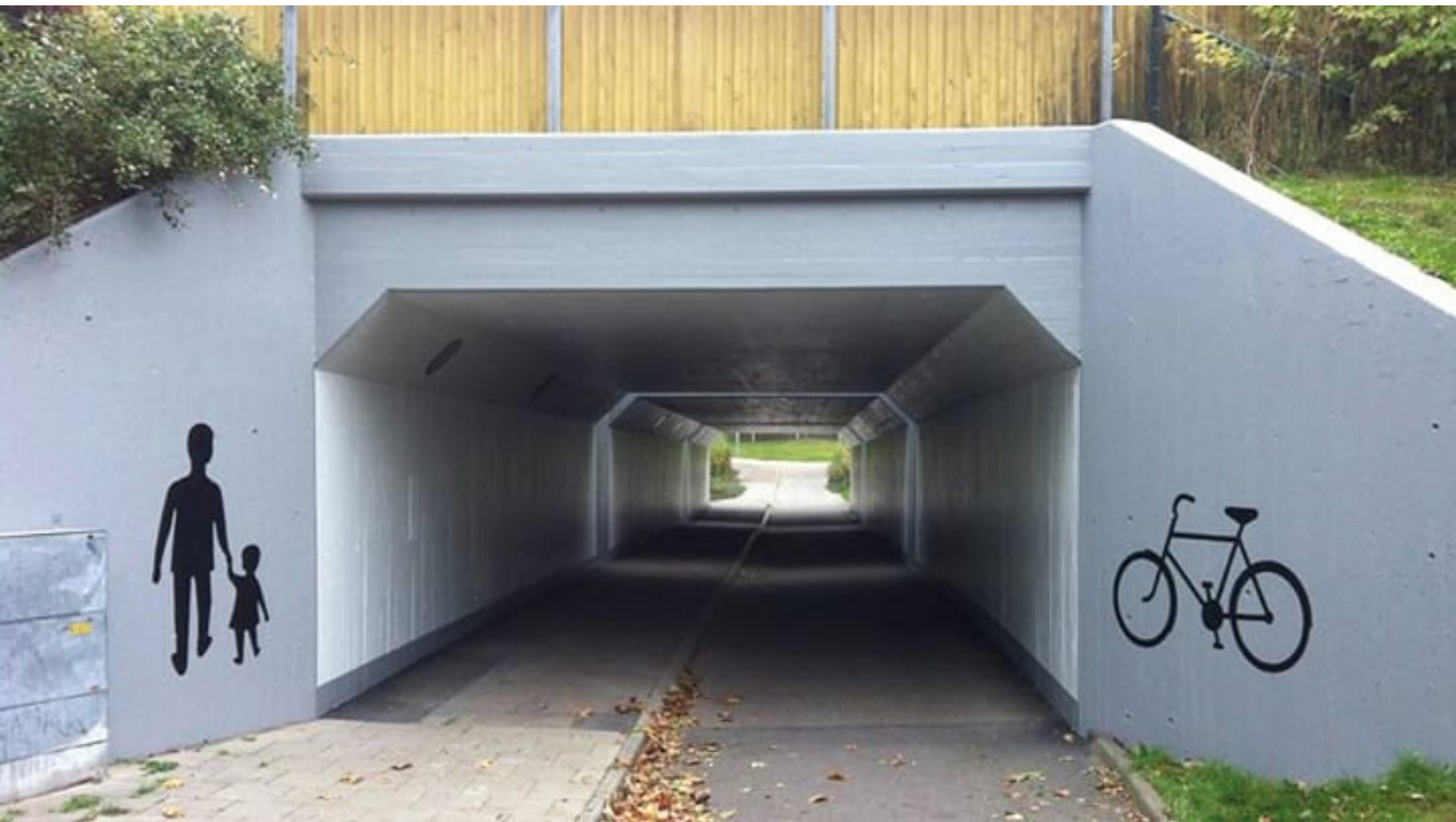
Gång- och cykeltunnel i Kävlings tätort.
