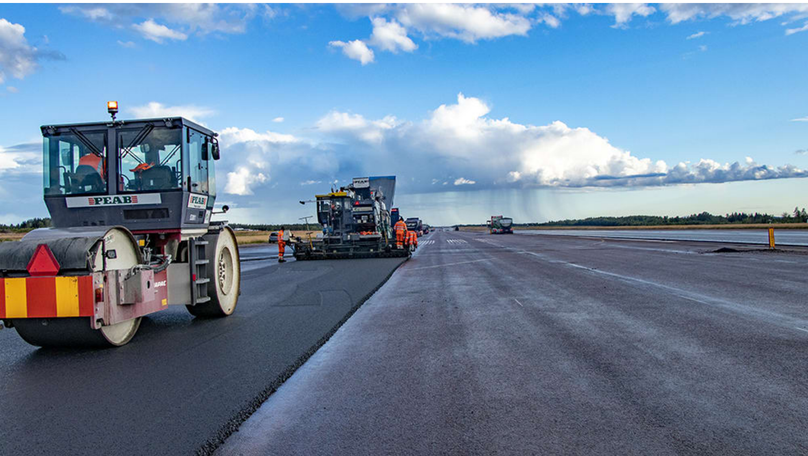
Omtopning av rullbanan
